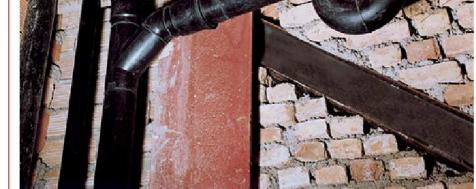
۶ در هنگام نصب و اجرای شبکه لازم را برای مسیرهای درنظر بگیرید و اتصالات و لوله‌ها را در مسیرهای افقی و عمودی با استفاده از بستهای مناسب ثابت کنید. لطفاً در صورت استفاده از دستگاه جوش به نکات مورد توصیه کارخانه سازنده توجه فرمایید.
